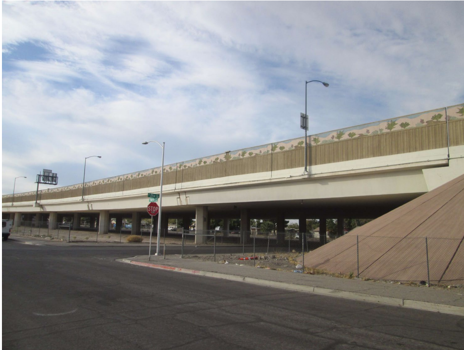
1 Figure 1-2. Las Vegas Viaduct
